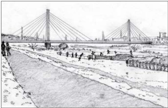
府中市四谷と日野市百草を結ぶ『府中四谷橋』、平成10年12月の完成、支柱から延びたワイヤーで橋桁を吊るスタイリッシュなフォルムが美しい。
